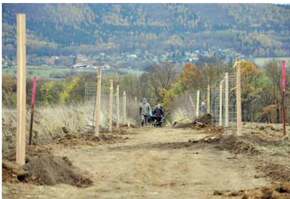
Obnova polních cest ve Svinařích.
