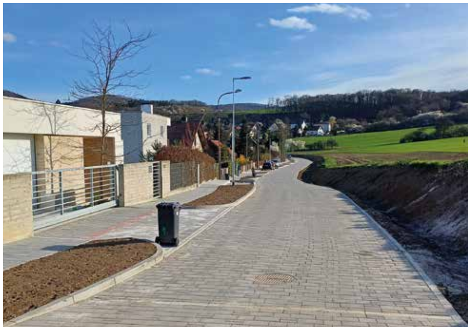
Rekonstrukce povrchů na Vrážce v Řevnicích.
