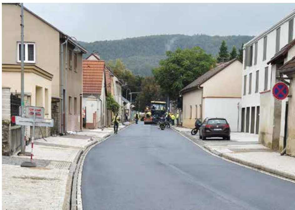
Rekonstrukce Palackého ulice v Dobřichovicích.
