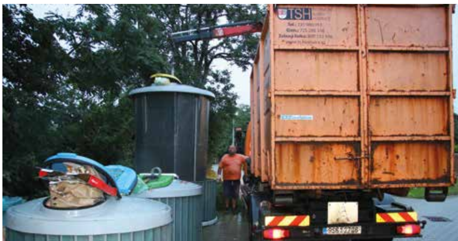
Klasické podzemní kontejnery v Letech.
