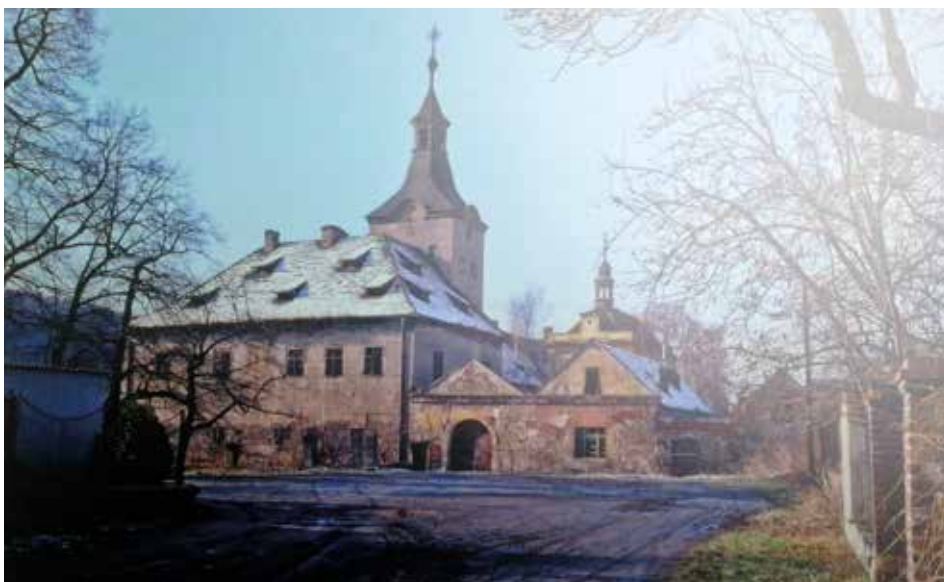
Před rekonstrukcí v roce 1998
