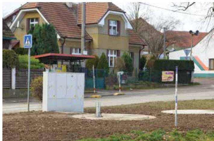
Čerpací stanice kanalizačního řadu v Zadní Třebani.
