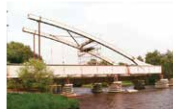
Výstavba mostu v roce 1996.
