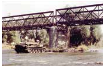
Bourání mostu v roce 1990.
