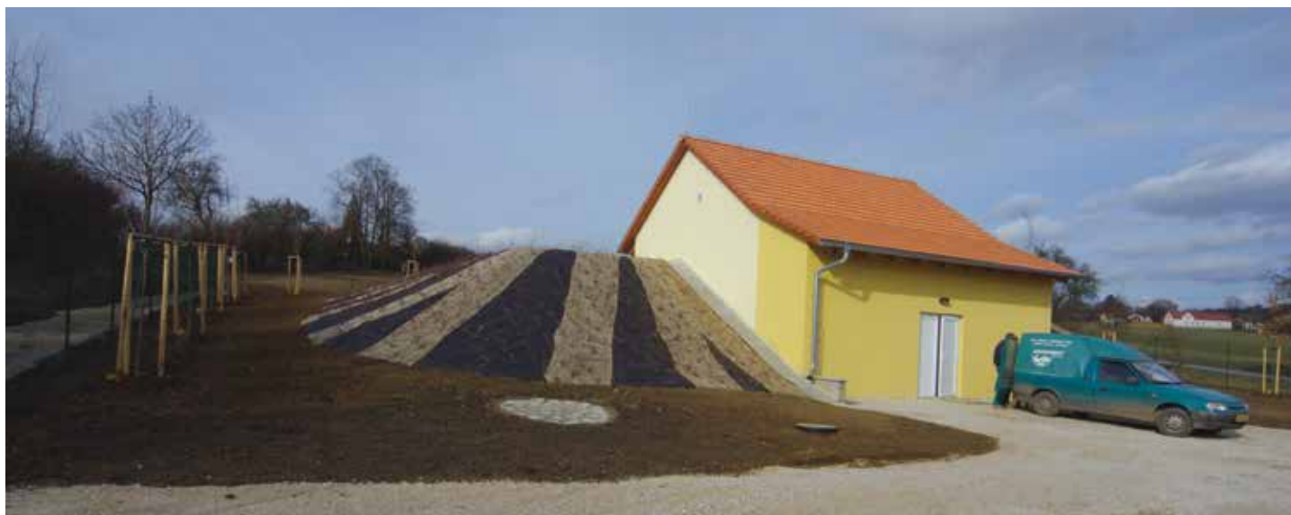
Nový vodojem spolu s přírodním potrubím a zásobovacím vodovodním řadem, vybudovaný svazkem obcí TřeMoLe
