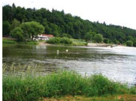
Jez v Dobřichovicích
