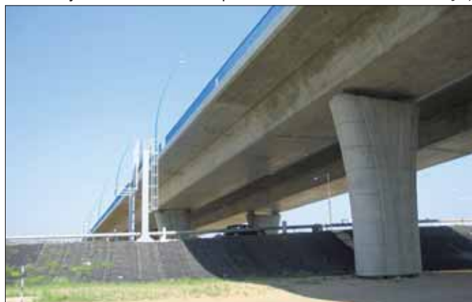
Část mostu Pražského okruhu
