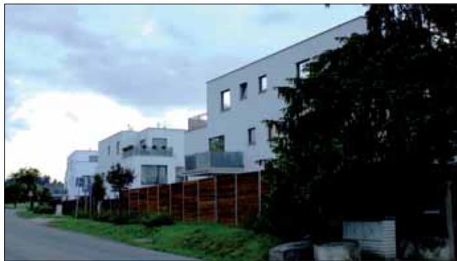
Bytové domy v Karlštejské ulici v Letech
