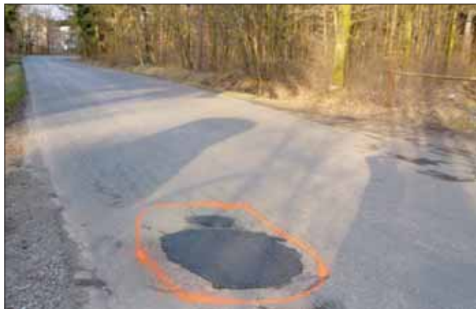
Provizorní způsob oprav silnice na Jíloviště
