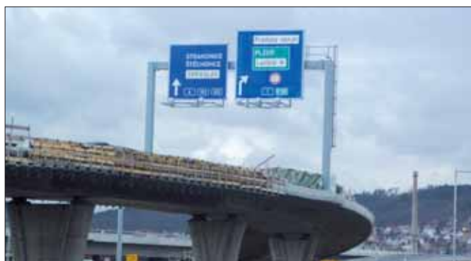
Stavba mimoúrovňové křižovatky na Strakonické Autor: M. Nešpor
