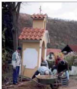
Stavba kapličky v Měchenicích
