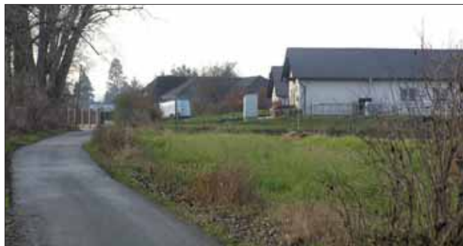
ČOV v Dobřichovicích
