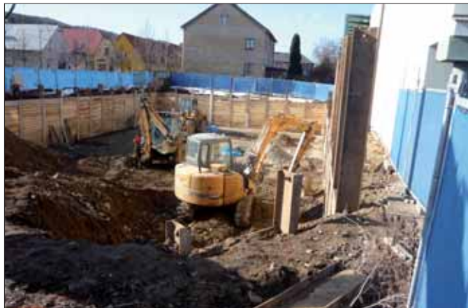
Stavba polyfunkčního domu Berounka
