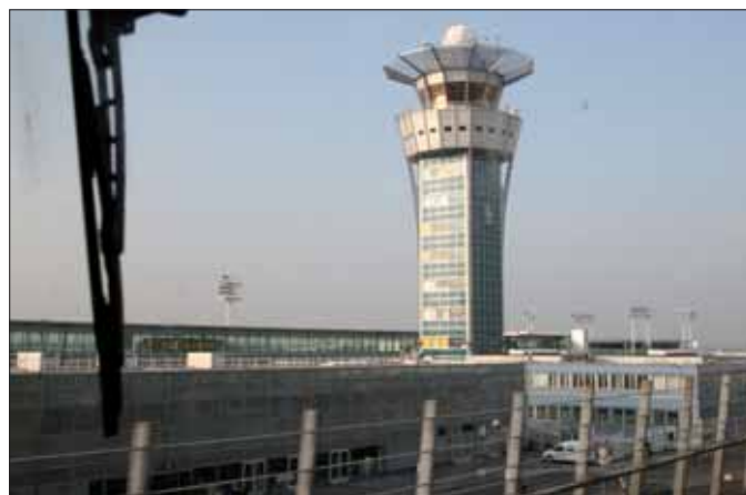
Pohled z jízdního ORLYVALu na řídicí věž letiště
